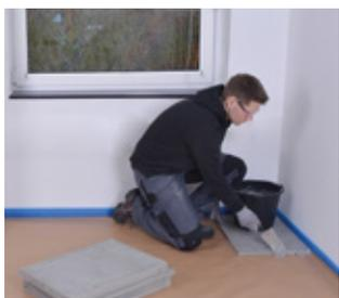
Epoxikleber entlang der Stosskante mit einer Kelle auftragen und nächstes Element fest anschieben. Fugenbreite mind. 2 mm.
