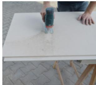
Letztes Element einer Reihe auf Länge kürzen (z. B. mit Kreis-sägeblatt Diamaster oder Stichsägeblatt T141 HM, Bosch).
