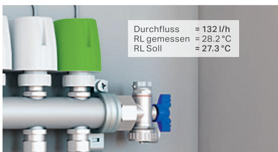
... mittels der stufenlosen 0-bis-10-V-Motoren wird der Durchfluss laufend gesenkt ...
