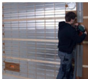
Zuleitungen und individuelle Rohrführungen werden mit Randelementen aufgefüllt und mit der Oberfräse ausgeschnitten.
