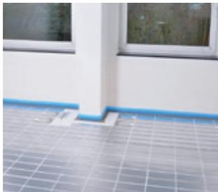
Geeignete druckstabile Trockenbau-Fussbodenheizung verlegen und vollflächig mit dem Untergrund verkleben.
