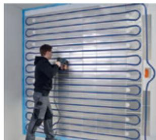
In den Sollbruchstellen oder zwischen den Elementen Löcher für die Wanddübel vorbohren.
