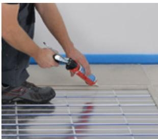
Die erste Klebeschnur nahe der Innenkante, die zweite Klebeschnur im letzten Drittel des Stufenfalzes gleichmässig auftragen (ca. 5 m<sup>2</sup>/Kartusche).
