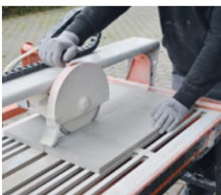
Zuschchnitt der Elemente mit einer herkömmlichen Diamanttrennscheibe ohne Wassereinsatz.
