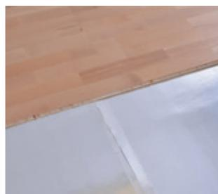
compact-floor direct ist nach der Verlegung direkt begehbar. Das Fertigparkett gemäss Herstellerangaben schwimmend verlegen.
