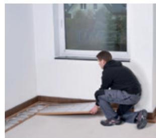
Die mit Wärmeleitblechen aus Aluminium versehenen Heizelemente vollflächig im Raum auslegen.
