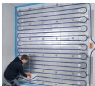
Aussparungen für Schalter oder Steckdosen auf das verlegte Armierungsgitter übertragen. Der Heizputz kann direkt auf die verlegte Heizfläche aufgebracht werden. Dabei die Herstellerangaben des Heizputzes beachten.
