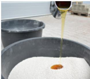
Gesamten Sackinhalt des Granulats in einen Mörtelkübel geben und den PU-Binder (1 Dose) vollständig hinzugeben.
