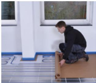
Geeignete druckstabile Trockenbau-Fussbodenheizung verlegen und Trennlage (Folie) darauf überlappend ausrollen.
