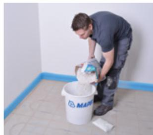
Für die Tragschicht einen Sack Planitex D10 mit 6.5l Wasser anrühren und einen Beutel Fasern (250 g) hinzufügen.
