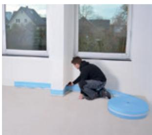
Randdämmstreifen verlegen und bei Bedarf in den Ecken leicht anritzen. Den sauberen Untergrund auf Tragfähigkeit überprüfen.
