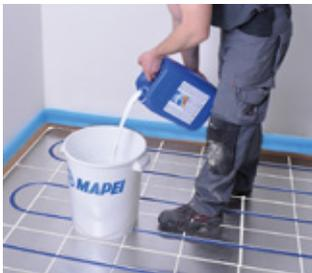
Einen Kanister Latex Plus und einen Sack Planitex D10 (~ 11 m<sup>2</sup>) mit langsam laufendem Rührwerk (max. 400 U/min) vermischen.
