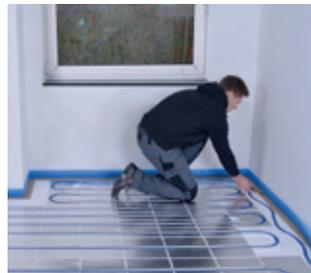
Randdämmstreifen vor der Verlegung von compact-floor direct bündig zur Fussbodenheizung abschneiden.
