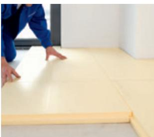
Dämmplatten auslegen. Platten im Verband, d.h. fugenversetzt und quer zur späteren Verlegung der compact-Elemente anordnen.
