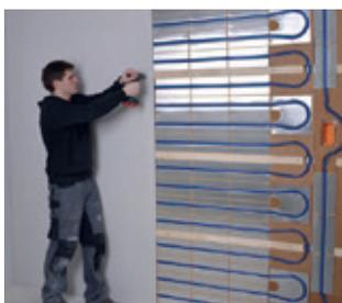
Bepankung mit Trockenbauplatten, z. B. 12.5 mm Gipsfaserplatte, auf der dafür vorgesehenen Konterlattung verschrauben.
