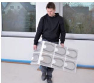
Elemente mittels Sollbruchstellen anpassen und Rand- und Eckbereiche mit Randelementen auffüllen. Niemals Aluminiumbleche schneiden!
