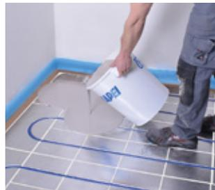
Anschliessend die Mischung auf den staubfreien und sauberen Heizelementen ausgiessen.
