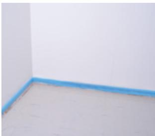
Bei 20 °C Raumtemperatur mind. sechs Stunden trocknen lassen. Kühlere Temperaturen (mind. 10 °C) verlängern die Trocknungszeit.
