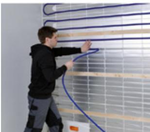
Heizrohr in einem Bogen in die Rohrführungen der Heizelemente drücken. Maximale Heizkreislänge 80 m.
