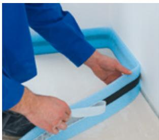
Randdämmstreifen verlegen und in den Ecken stumpf stossen
