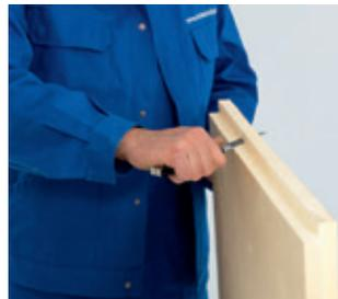
Stufenfalz (falls vorhanden) bei den ersten Dämmplatten für einen vollflächigen und dichten Anschluss an Wand und Untergrund entfernen.
