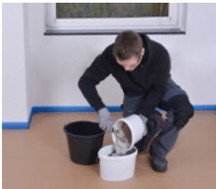
Komponente B (2 kg) in Komponente A (4 kg) geben und vollständig verrühren. Schutzbrille und Handschuhe tragen.
