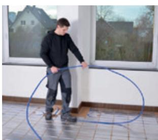
Systemrohr in einem grossen Bogen von oben spannungsfrei in die Rillen drücken. Maximale Heizkreislänge 100 m.
