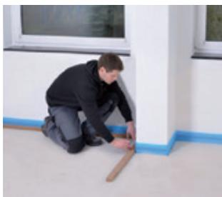
Randdämmstreifen auslegen und Rahmenhölzer auf sauberen, tragfähigen Untergrund verlegen.
