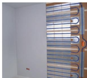
Fertig montierte Wandfläche System compact-oeko mit Konterlattung. Ränder als Bewegungsfuge (mind. 5 mm) mit elastischem Versiegelungsmaterial abdichten und Übergangsfugen verspachteln. Bei der Montage der Trockenbauplatten die jeweiligen Herstellerangaben beachten.
