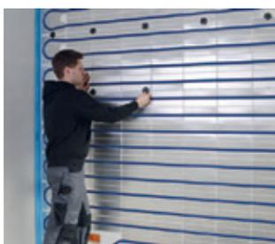
Auflageteller in die vorgebohrten Löcher einstecken. Auf einem Quadratmeter werden acht Dübel benötigt.
