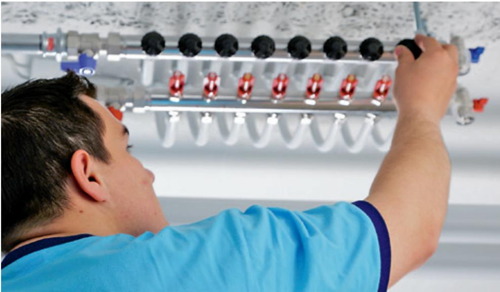
Eine Fussbodenheizung kann die berechneten Leistungswerte nur dann erbringen, wenn sie einerseits gemäss Planung verlegt wurde und wenn andererseits die einzelnen Heizkreise gemäss Dimensionierungsberechnung hydraulisch untereinander abgeglichen werden.
