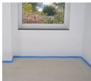
Nach 3 – 4 Stunden Trocknungszeit ist die Fläche begehbar und nach 24 Stunden belegbar.
