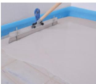
Die flüssige Tragschicht mit einem Stiftrakel auf 9 mm abziehen.
