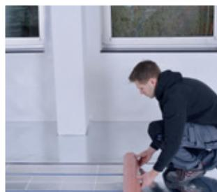
compact-floor direct Bahn für Bahn spannungsfrei verlegen. Stosskanten dabei nicht überlappen.
