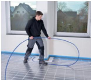
Anschliessend das Rohr nach Herstellerangaben in einem grossen Bogen von oben spannungsfrei verlegen.
