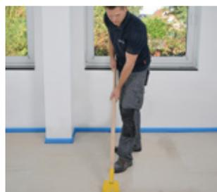
Nach 24 Stunden Trocknungszeit lässt sich der überschüssige Kleber mit einem Spachtel entfernen. Anschliessend kann der Bodenbelag verlegt werden (beachten Sie unsere Freigaben → Datenblätter Bodenbeläge | Kleber).
