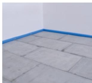
Nach 24 Stunden Trocknungszeit ist compact-floor 20 begeh- und belegbar. Alle Bodenbeläge können verlegt werden.
