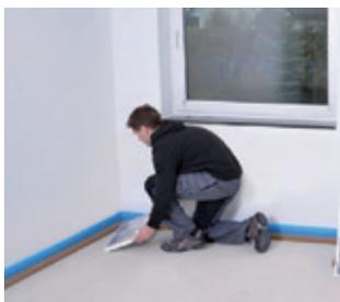
In einer Ecke mit Kopfelementen beginnen. Zur besseren Rohrmontage werden Kopfelemente mit Aluminium empfohlen.
