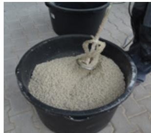
3 Minuten mit einem Rührwerk sorgfältig mischen. Für ein besseres Mischergebnis in einen zweiten Mörtelkübel umtopfen und 1 Minute nachmischen.
