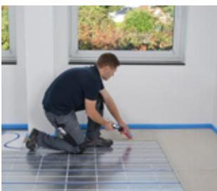
Mit Reststück ( $\geq 20$  cm) im schlep-penden Verband beginnen (Fugen-versatz  $\geq 20$  cm). Stufenfalz mit zwei Klebeschnüren ( $\varnothing$  ca. 5 mm) versehen.
