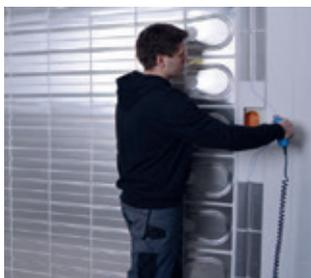
Mit dem Heisschneider individuelle Rohrführungen ausschneiden. Lange Rohrführungen in Wellenlinien ausschneiden.
