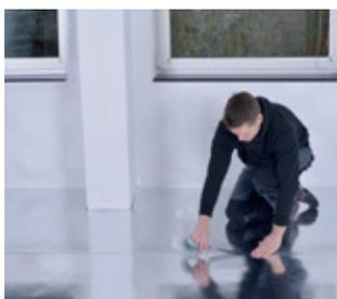
Alle Stosskanten mit compact-floor-direct-Aluminiumklebeband zur Abdichtung und optimalen Wärmeübertragung verkleben.
