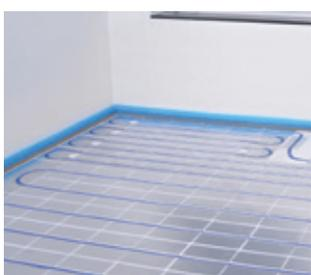
Fertig verlegte Fläche System compact-neo 20. Bis zur Verlegung der Lastverteilschicht oder des Oberbodens Laufwege, z. B. mit Dämmplatten, vor Stauchung schützen. Der Oberboden kann direkt verlegt werden.
