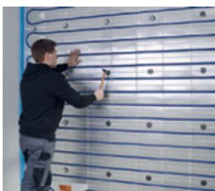
Armierungsgitter in Bahnen zuschneiden und mit 10 cm Überlappung mithilfe der Schlagdübel fixieren.
