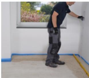
Dämme anhand des Meterrisses im Höhenprofil ausbilden. Schichtstärke min. 10 mm bis max. 100 mm.
