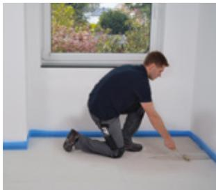
Randdämmstreifen auslegen, Untergrund sorgfältig reinigen und für eine ausreichende Haftung mit Tiefengrund grundieren. Bei Schichtstärken bis 30 mm ist eine PU-Grundierung zu verwenden.
