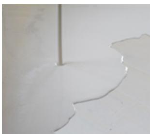
Tragschicht von Hand oder mit einer Fließüberzugpumpe gleichmässig einbringen und ansatzlos auf durchgetrockneter Kontaktschicht verteilen.
