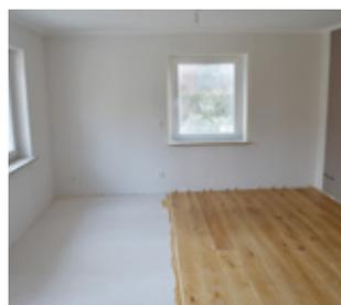
Nach frühestens vier Tagen Trocknungszeit das Aufheizprotokoll compact-floor liquid 10 durchführen. Anschliessend kann (ab dem siebten Tag) der Oberboden verlegt werden.
