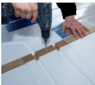
Im Türdurchgang das Rahmenholz wenn möglich im Untergrund verschrauben. Übergangsschienen lassen sich so später leicht anbringen.
