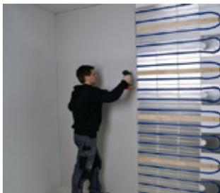
Bepankung mit Trockenbauplatten, z. B. 12,5 mm Gipsfaserplatte, auf der dafür vorgesehenen Konterlattung verschrauben.
