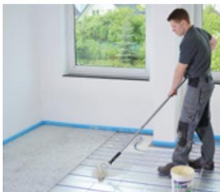
compact-floor 5 bei Fliesenbelag vollflächig auf den Heizelementen mit Kleber, z. B. Eco Fix von Mapei, fixieren.
