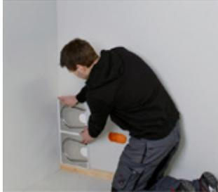
Mit Kopf- oder Randelementen beginnen. Zur besseren Rohrmontage werden Kopfelemente mit Aluminium empfohlen.
