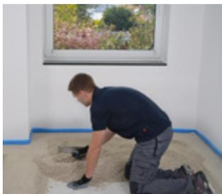
Fläche zwischen den Dämmen auffüllen und mit Kelle klopfend verdichten.
