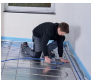
Nach Rohrbögen das Systemrohr nicht hochziehen. Bei Bedarf den Bogen nachträglich nach unten biegen und in die Rohrrille einlegen.
