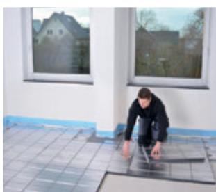
Heizelemente mittels Sollbruchstellen anpassen. Kleinere Stücke nach Möglichkeit in der Raummitte verlegen.
