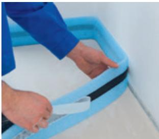
Randdämmstreifen an der Wand befestigen. Enden dürfen nicht überlappen. Höhe der Gesamtkonstruktion beachten.
