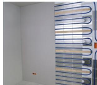
Fertig montierte Wandfläche System compact-plus mit Konterlattung. Ränder als Bewegungsfuge z. B. mit Acryl abdichten und Übergangsfugen verspachteln. Bei der Montage der Trockenbauplatten die jeweiligen Herstellerangaben beachten.
