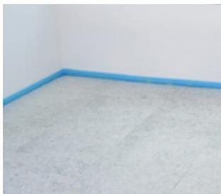
Bei der komplett mit compact-floor 5 verlegten Fläche ist auf eine spannungsfreie Montage zu achten.
