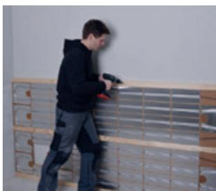
Für die spätere Befestigung der Trockenbauplatten wird nach jedem Feld (50 cm) ein gehobeltes Kantholz 30 x 50 mm befestigt.
