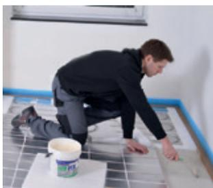
Bei leichten Konstruktionen (z. B. Parkett Direktaufgabe) Elemente vollflächig mit Kleber, z. B. Eco Fix von Mapei, fixieren.
