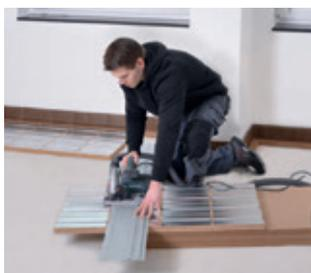
Nach Bedarf die Heizelemente zwischen den Wärmeleitblechen zuschneiden. Niemals Aluminiumbleche schneiden!
