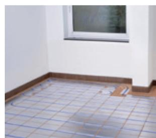
Fertig verlegte Fläche System compact-oeko 30. Bis zur Verlegung der Lastverteilschicht oder des Oberbodens Laufwege, z. B. mit Dämmplatten, vor Stauchung schützen. Der Oberboden kann direkt verlegt werden.
